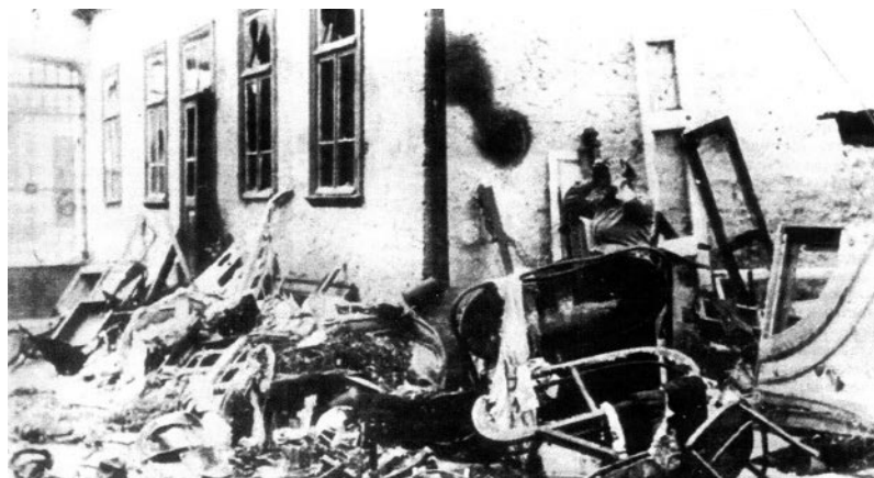
Разрушенные и подожженные дома. После Кишиневского погрома 1903 г.
